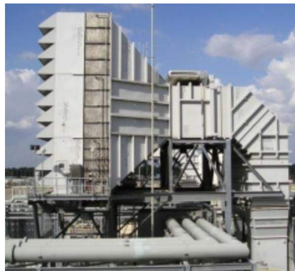
Pneumafil Gas turbine air intake 纽曼菲尔燃气轮机进气过滤器 Filter and cooler 除尘器和冷却器 1,000,000 - 2,000,000 m 3 /h
